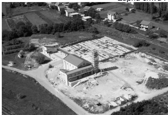
Kompleks u tijeku gradnje 2006. (f. F. Ratković)
